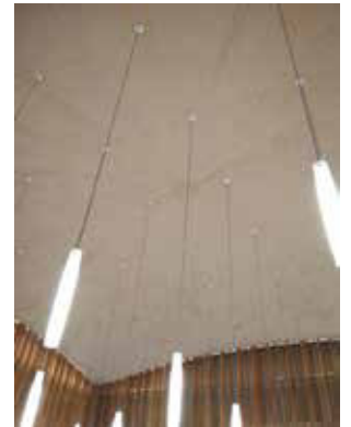
Die freitragende gewölbte Holzkuppel auf vier Eckpfeilern.
